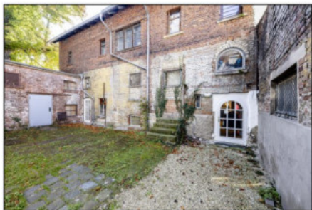
Gemeinsamer Innenhof zur Bruchstraße 4
