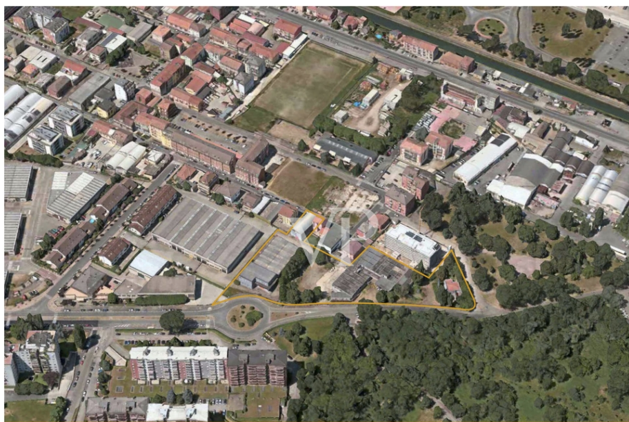
FOTO AEREA CON PERIMETRAZIONE AREA D' INTERVENTO
